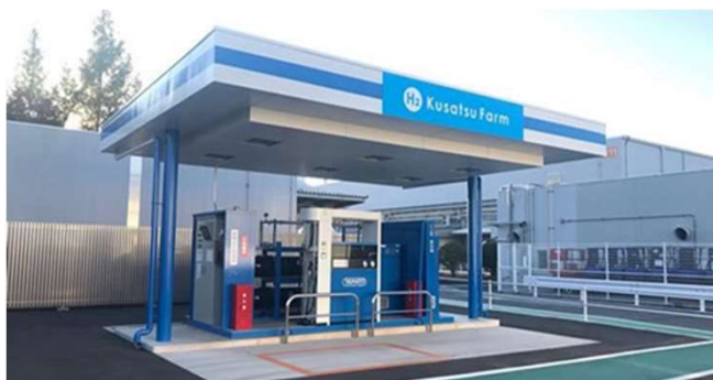
図5 ヤマト・H 2 Energy Japan社製パッケージを利用した水素ステーション「H 2 Kusatsu Farm」 ( https://news.kakaku.com/prdnews/cd=kuruma/ctcd=7010/id=89750/ )
