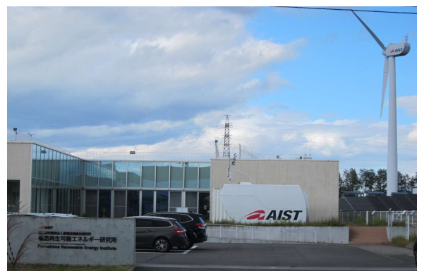
図3 FREAのエネルギー管理棟と風力発電設備
